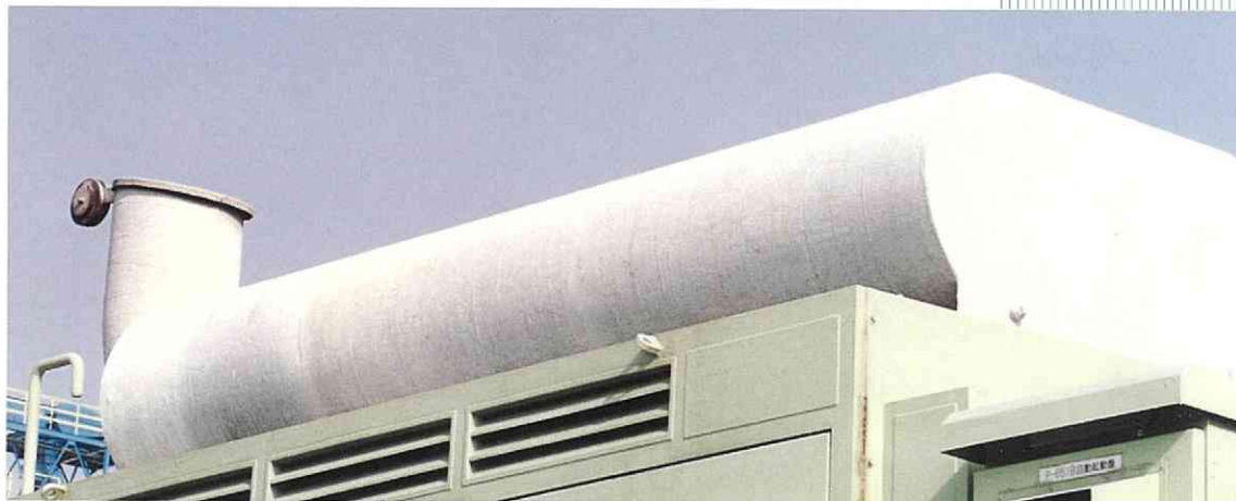
▼ディーゼルエンジン マフラー部施工例
