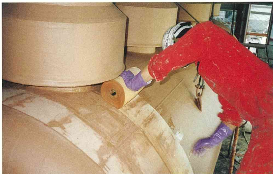
▼地下埋設タンク
