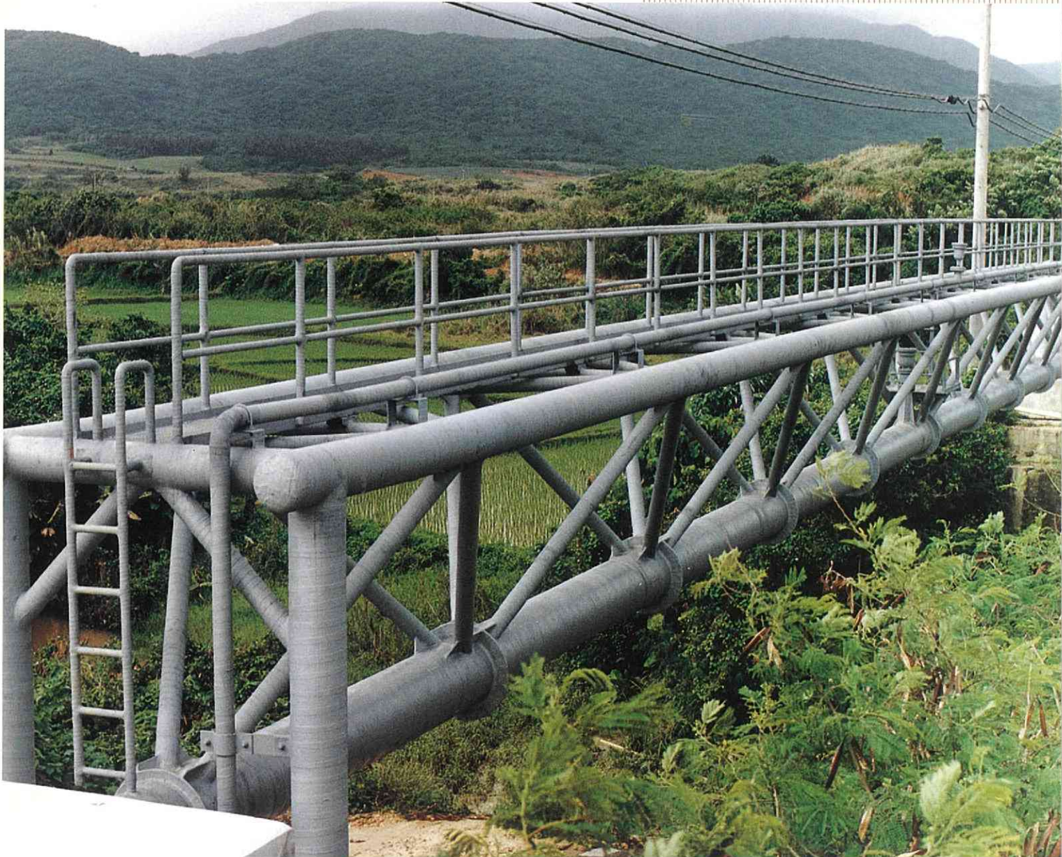
▼トラス型水管橋の防蝕
