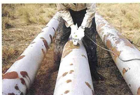
①素地調整(2種研錆) (脱脂)
