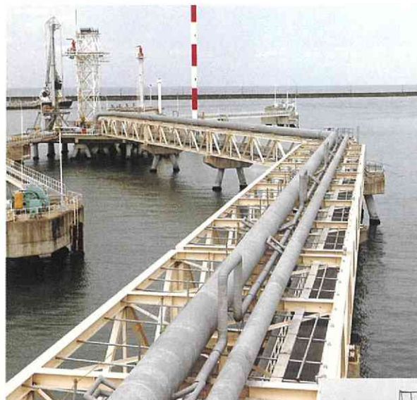
▼ 棧橋配管の防水・防蝕
