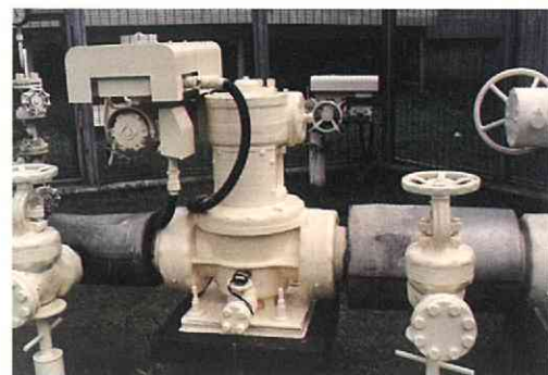
▲バルブ防蝕施工
