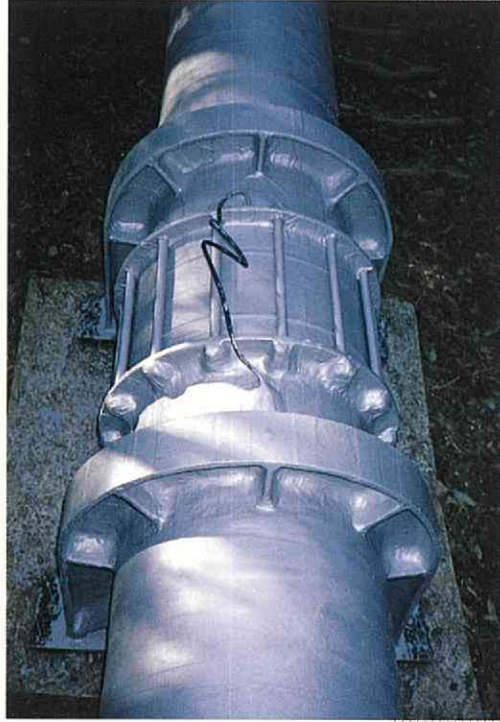
▼送水本管の防蝕
