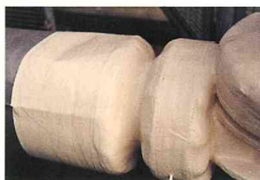
▲フランジ防蝕施工
