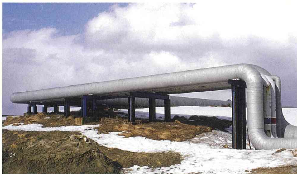
▼ 原油受入基地設備の防水・防蝕
