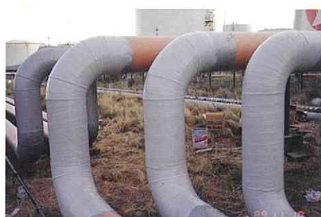
③ 中塗り、L部のテープ施工
